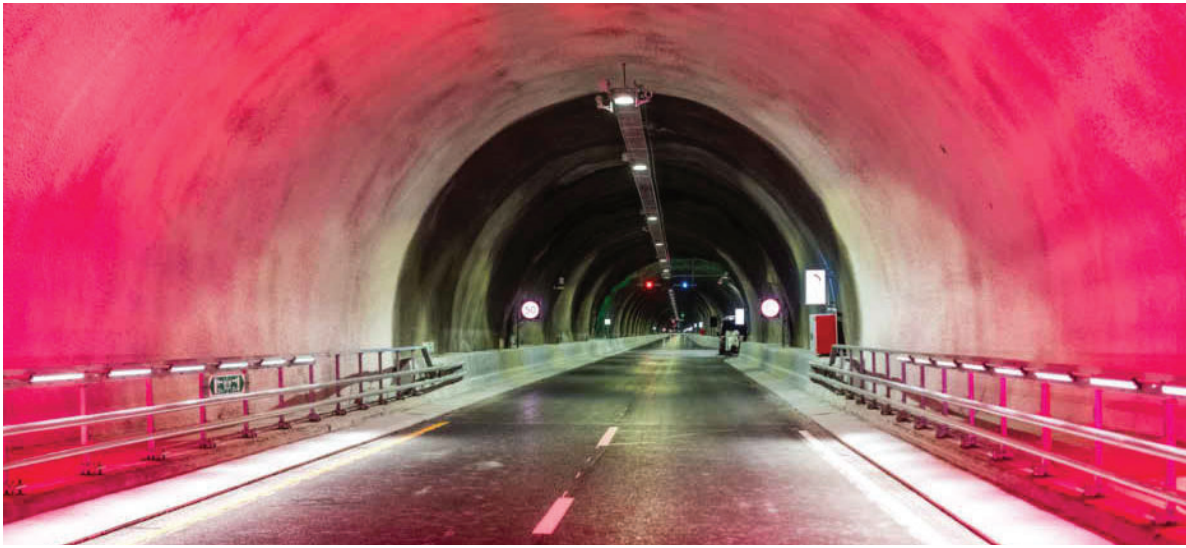
De mange, og lange tunnelene i Norge – også under fjorder, som Ryfast-tunnelen – har med seg utfordringer for risiko, sikkerhet og beredskap som krever samarbeid mellom ulike aktører, og det er behov for ny kunnskap.
